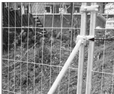
Mit den Befestigungssätzen für Bauzäune... Art.-Nr. 29340 (aus Stahl) bzw. ...
